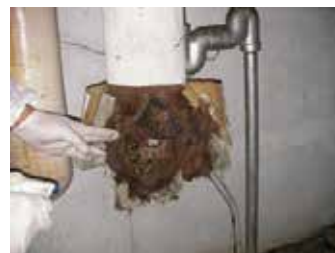
アスベストの採取状況 (1)
