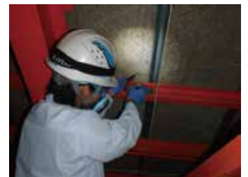
アスベストの採取状況 (2)
