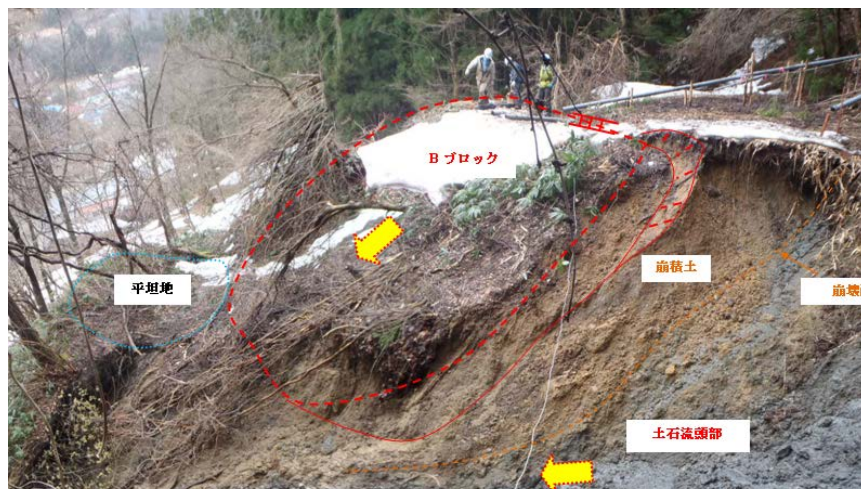
写真-1 発生した滑落崖及び伸縮計設置状況
