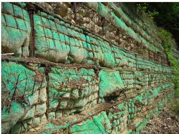
籠枠工（強酸性土壌により溶接金網がボロボロ）
