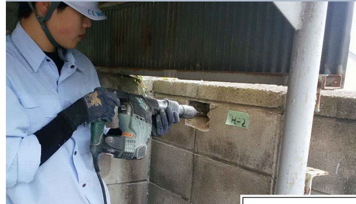
鉄筋の接合状況調査
