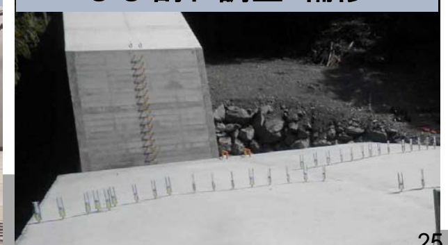
ひび割れ調査・補修
