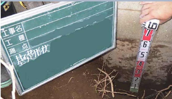
基礎形状の掘削調査
