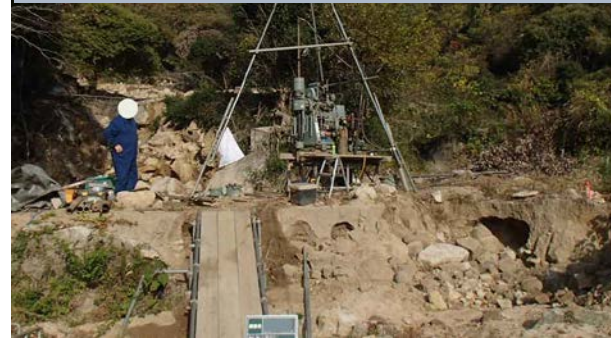
ボーリング調査
