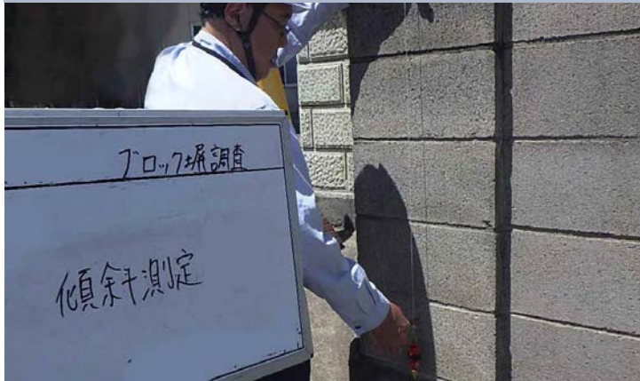
傾斜量の測定
