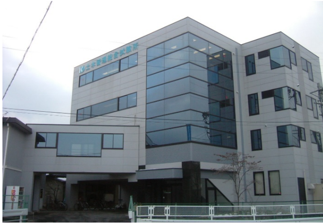
環境分析センター（長野県長野市）
