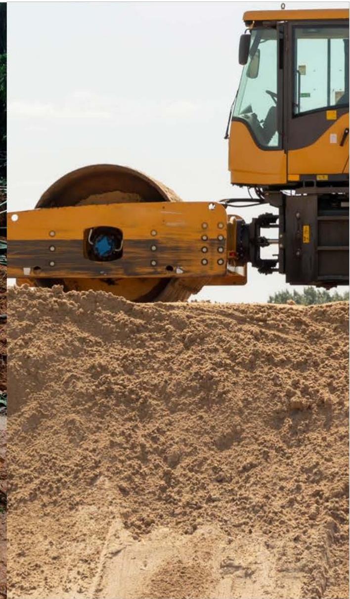
施工品質の管理
