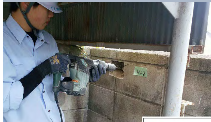
鉄筋の接合状況調査
