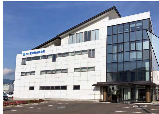
中央試験センター(長野県千曲市)
