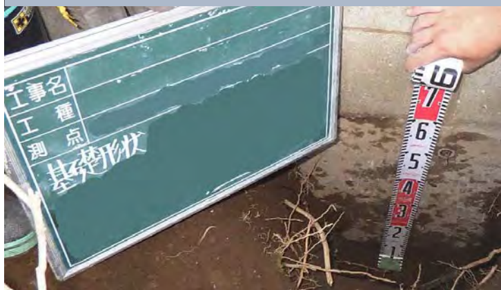
基礎形状の掘削調査
