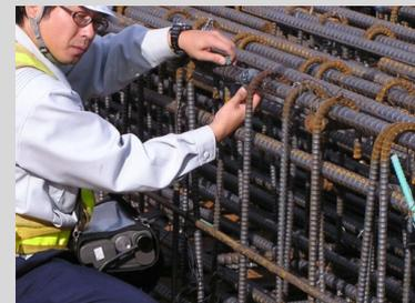
圧接部超音波探傷検査
