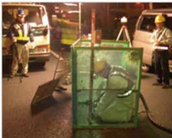
飛散養生柵の使用
