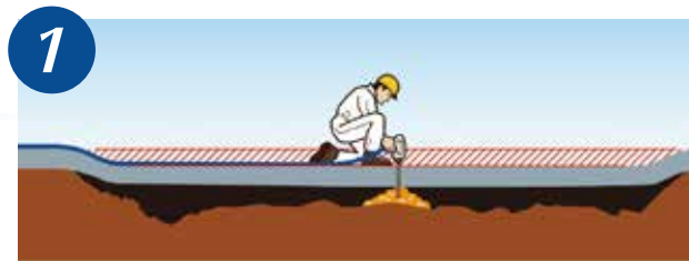
傾きを計測し修正箇所1円玉より小さい注入孔をあけます。
