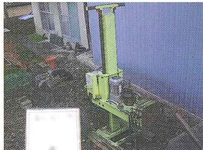
【地盤調査(スウェーデン式サウンディング試験)】
