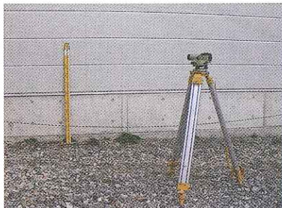
【不同沈下量測定】
