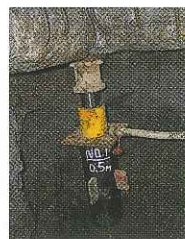
▲鋼管圧入・ジャッキアップ
