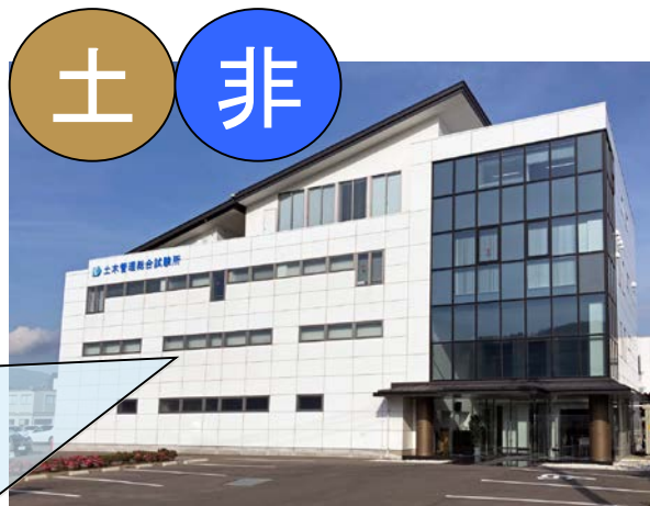
中央試験センター(長野県千曲市)
