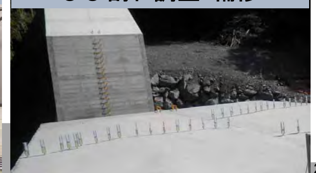
ひび割れ調査・補修
