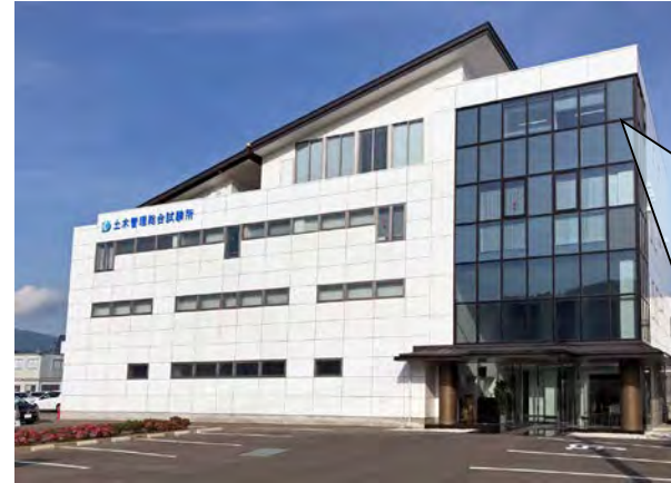
中央試験センター(長野県千曲市)
