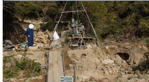
ボーリング調査
