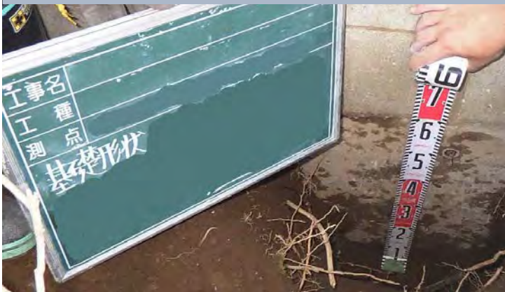
基礎形状の掘削調査
