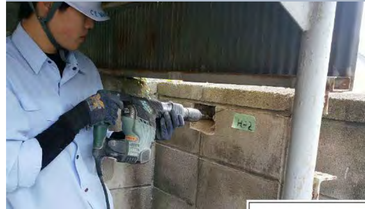
鉄筋の接合状況調査
