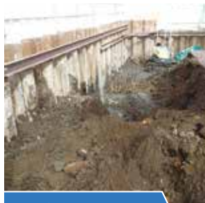
土壌浄化工事
