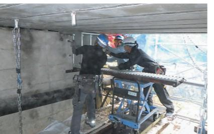
耐震補強ブラケット取付工事は、橋がたが地震時に落下しないようにしたり、地震でずれたり段差が生じたりしないようするために設置される部材(ブラケット)で、主に橋梁下部工に鋼製部材をアンカーによりブラケットを固定し設置されます。事前の鉄筋探査からあと施工アンカーの設置・定着、ブラケット製作・設置、品質管理まで一貫対応致します。
