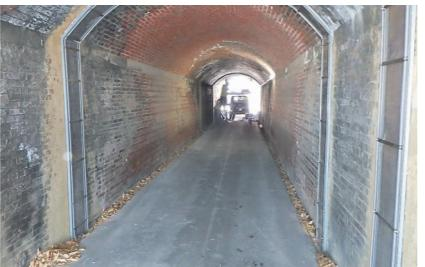
線導水工法は、主にトンネルの目地やひび割れからの漏水に対し、塩ビや合成樹脂製の管をアンカーで設置することで排水系統へ導き、路面凍結や劣化を防止します。施工は簡単で耐久性も高く、調査・分析から施工・品質管理まで一貫対応し、トンネルの安全性を確保します。
