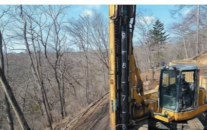
スーパーNP-PACK工法ecoは、鋼管杭を高圧で圧入することで地盤を補強する工法です。無振動・無排土・低騒音で環境に優しく、短期間で施工可能。粘性土や砂質土など多様な地盤に対応し、都市部でも有効です。
