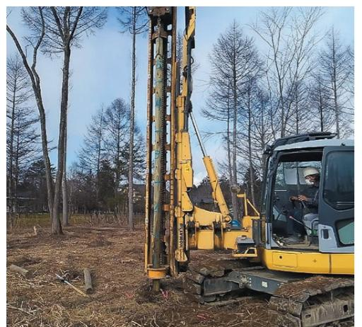
環境パイル工法は、木材で家を支える環境に優しい地盤改良工法です。木材には高品質の防腐・防蟻処理を施し高耐久性の材料を使用しています。小規模建築物に適しています。環境負荷を抑えつつ、地盤の支持力を確保できるため、住宅や公共施設などに有効です。
