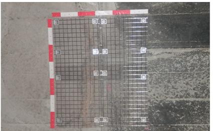
ネット工法は、FRP製ネットをアンカーで固定し、剥落片の落下を防止する工法です。主にトンネル目地部やコンクリート縫合部に適用されます。調査・分析から施工・品質管理まで一貫対応し、信頼性を確保します。
