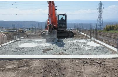
公共施設や道路工事などで広く使われる汎用的な地盤改良工法です。浅い地盤に対し、地耐力のばらつきや軟弱層に対応し、強度と均質性を確保。掘削した土にセメント系固化材を混ぜ、災害に強い地盤を形成します。
