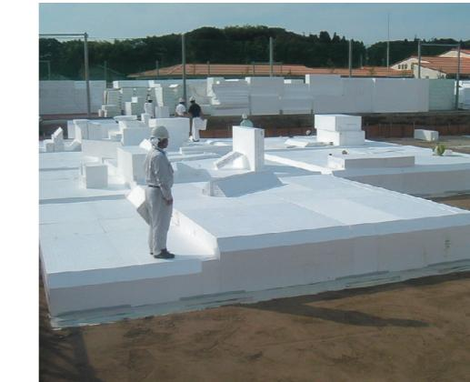
コロンブス工法は、基礎下の土を撤去し、EPS製ジオフォームを敷設する地盤置換工法です。不同沈下を防ぎ、地震や振動の影響を緩和。軟弱地盤に有効で、建物の安全性向上と環境負荷低減に貢献します。
