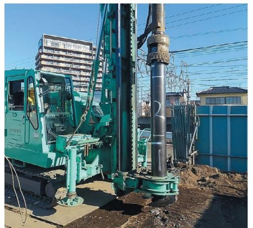
ALKTOP工法は、鋼管杭を回転貫入して地盤を補強する技術です。低騒音・低振動で周辺環境に優しく、セメント系固化材を使わないため環境負荷も低減。住宅地などでも安心して施工できる工法です。
