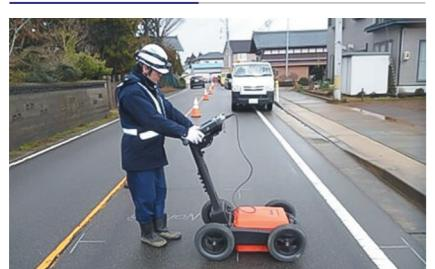
地中レーダ法は、パルス波の反射解析で地下の空洞や埋設物を非破壊で特定します。材質による管を計測でき、工事中の破損事故を防止。効率的な広範囲調査で施工計画に役立ちます。
