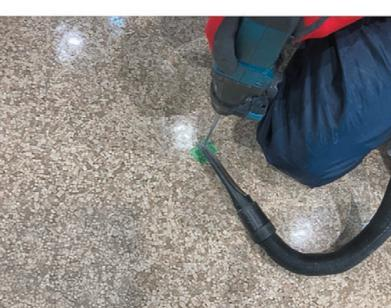
テラテック工法は、コンクリート土間床下に硬質ウレタン「テラテック樹脂」を注入し、その膨張力で沈んだ床を水平に戻し、床下の空洞を埋める特許工法です。この工法は、床の解体を必要とせず、短時間で施工が完了し、廃棄物も少ないため、環境に優しい特徴があります。
