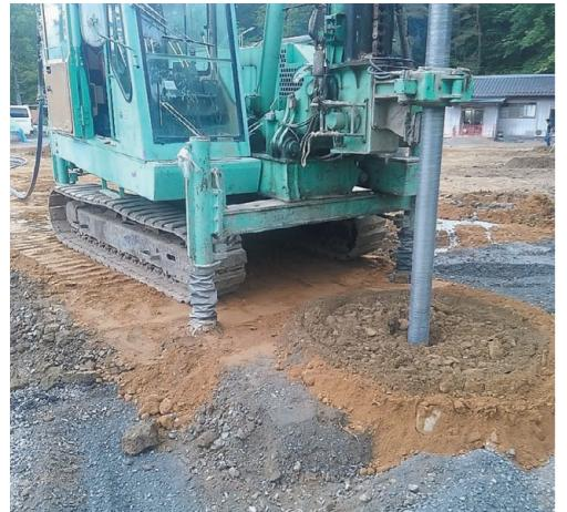
ファインパイル工法Civ.は、セメントスラリーに界面活性剤(KNNスラリー-20)を添加し混合攪拌することで、初期流动性を化学的に促進させ強度を確保した柱状の改良体を地盤中に形成する工法です。従来工法に比べ施工品質のばらつきを抑え、軟弱地盤での支持力向上や沈下防止に効果的です。さらに、環境負荷の低減や施工効率の向上にも寄与し、信頼性の高い地盤補強を実現します。品質確保と環境配慮を両立する次世代の改良工法です。
