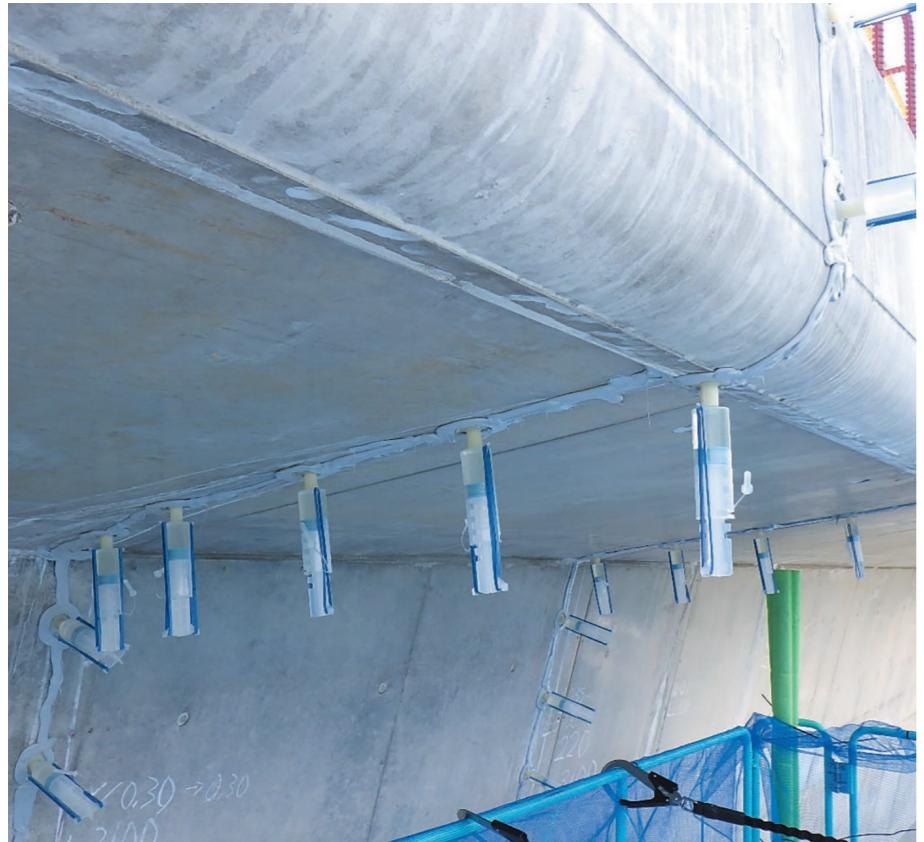
ひび割れ注入工法は、0.2~1.0mmのひび割れに適用され、ひび割れ内部に注入材を注入することで、劣化因子の侵入を防ぎます。エポキシ樹脂やセメント系注入材を低圧で注入し、硬化後に強度と耐久性を回復。事前調査・分析から施工・品質管理まで一貫対応し、構造物の長寿命化に寄与します。
