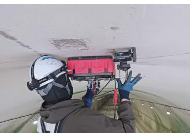
地中レーダによる覆工背面調査は、電磁波の反射解析で空洞や欠陥を特定する非破壊技術です。覆工コンクリート表面に計測器を設置し、縦断方向および横断方向に走査することで異常箇所を検知し、そのデータをもとに補修計画や安全性評価を行います。
