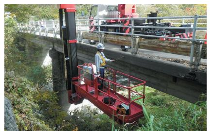
維持管理や補修計画に必要な情報を得るために、橋梁点検の目視調査を実施します。部材を至近距離で確認し、異常を把握。打音検査や触診を併用し、劣化原因の推定や健全性を評価。国土交通省や自治体要領に準拠して実施します。
