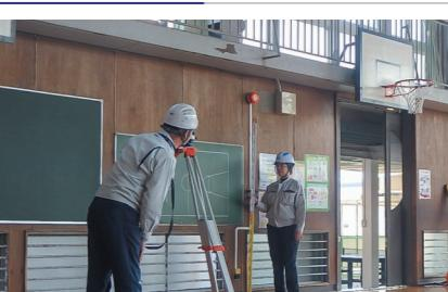
不同沈下量の測定は、オートレベル等により建物の柱付近の高低差を測定し、相対的な沈下量を算出すること沈下の程度を評価します。著しい沈下は健康被害や地盤の空洞など建物の長期的な使用や維持管理に影響します。
