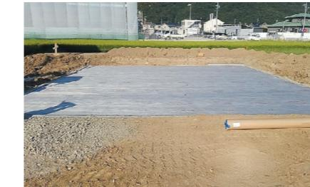
GRRシート工法は、所定の厚さを有する碎石地盤中にジオテキスタイルを敷設することで、碎石地盤による地表面付近の剛性補強効果と、シートによる碎石層の変形拘束効果によって、支持力補強効果を得ることができる技術です。
