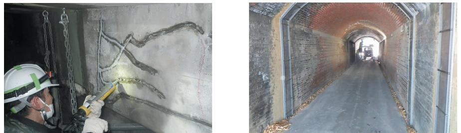
裏込め注入工法は、トンネル覆工背面の空洞を注入材で充填し、地山の緩みや漏水を防止します。セメント系や発泡ウレタン系を用い、圧力管理を徹底。調査・分析から施工・品質管理まで一貫対応し、トンネルの安定性と耐久性を高めます。
