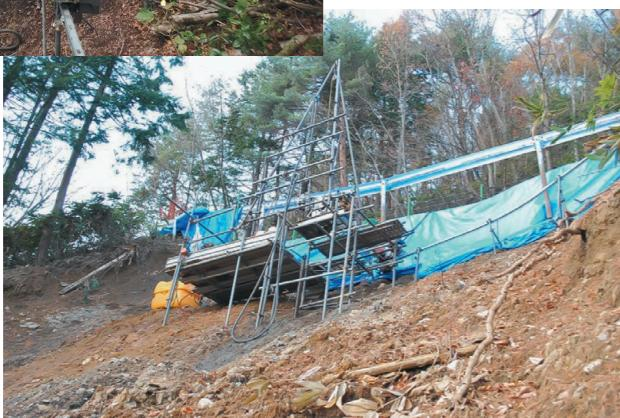
ボーリング調査は、地すべりや土砂災害のリスクを評価・軽減するための重要な調査です。地層の構造や強度を把握し、採取した試料を詳細に分析することで、地盤の安定性を科学的に確認します。資機材の搬入は主にクローラやモノレールを使用し、場合によっては索道やヘリコプターによる搬入を行う場合もあります。得られたデータは、地すべり対策や防災計画の立案に活用され、災害リスクを低減し、安心・安全な施工や維持管理に貢献します。
