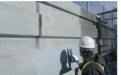
はく落防止工法は、劣化によるコンクリート片の落下を防ぐ方法です。繊維シートやFRPネットを貼り、樹脂で補強。施工は簡易で耐久性も高く、外観を変えません。調査・分析から施工・品質管理まで一貫対応し、安全性と信頼性を確保します。
