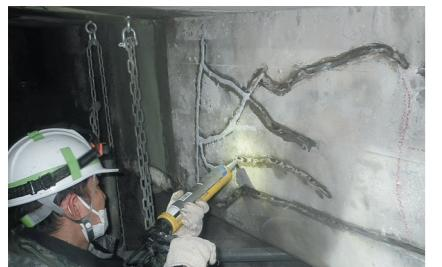
コンクリート構造物の耐久性を確保するには、適切な調査と補修が重要です。ひび割れ部分をU字にカットし、プライマーで下地との密着性を高めた上で、エポキシ樹脂やポリマーセメントモルタルを充填。硬化後に平滑仕上げを行い、耐久性を回復するとともに、構造物の品質と信頼性を向上させます。
