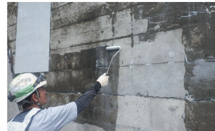
表面含浸工法は、コンクリート表面にシラン系やケイ酸塩系含浸材を塗布し、撥水・緻密化効果で劣化因子を防ぎます。外観を変えず、短期間・低成本で施工可能。調査・分析から材質選定、施工・品質管理まで一貫対応し、耐久性と信頼性を高めます。
