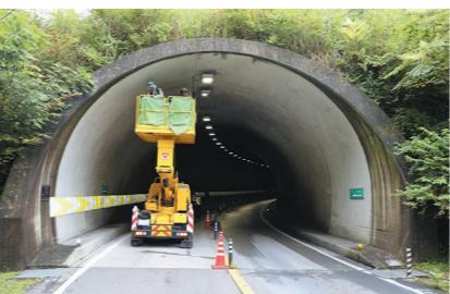
トンネル定期点検における目視調査は、点検員が徒歩または点検車を使用し、ひび割れや漏水、浮き、剥離等を確認します。点検結果は国土交通省や自治体の要領に従って調書を作成し、維持修繕計画に活用します。
